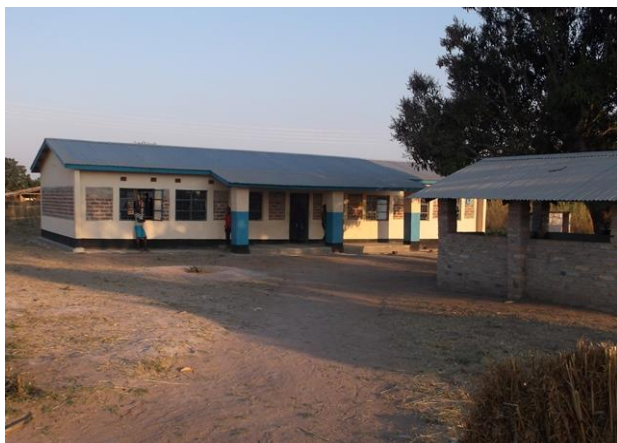
Nach dem Mädchentrakt 2013 konnte 2015 ein weiterer Wohntrakt für Jungen fertiggestellt werden.
