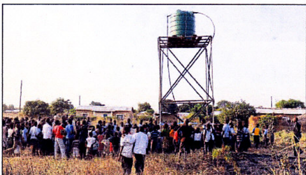
Gerade einmal 2000 Liter Wasser kann dieser Tank an der Schule in Kayambi speichern. Eine zuverlässige Wasserversorgung aus mehreren Brunnen soll jetzt entstehen. Nach dem Ende der Trockenzeit im November soll gebohrt werden. Dafür und für die spätere Technik wird dringend Geld gebraucht.
