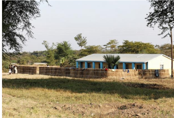
Der Wohntrakt für Mädchen an der Schule in Kayambi wurde 2013 fertiggestellt.
